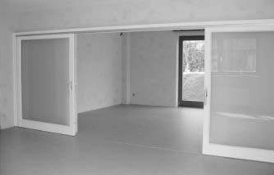
Die Schiebetür macht die beiden Gruppenräume zu einem „kleinen Saal“.
