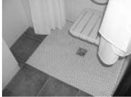
Die Dusche zu Hause entspricht jetzt den pflegerischen Anforderungen.
