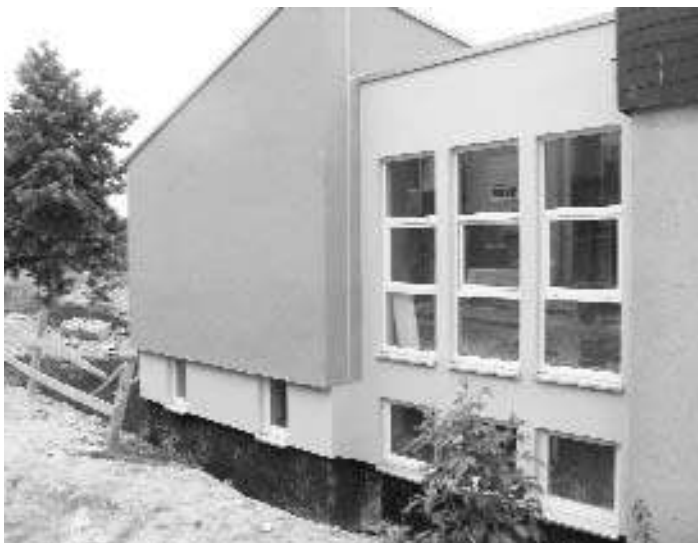
Das Grete-Meißner-Zentrum wurde um diesen Anbau erweitert.
