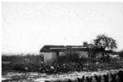
1981: Draußen noch Baustelle – drinnen die gerade fertig gestellte Altentagesstätte.
